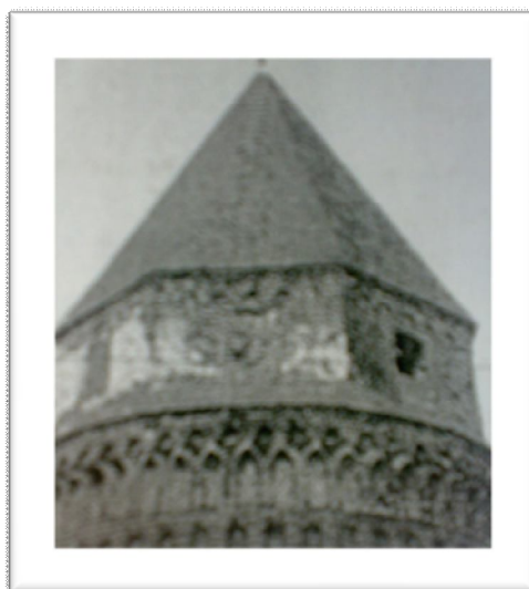
بابل - بقعه درویش فخرالدین - چیدن گنبد بصورت رگچین
