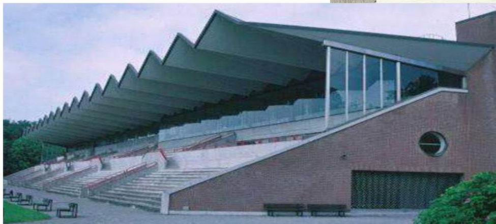
سازه‌های با سقف تاشو
