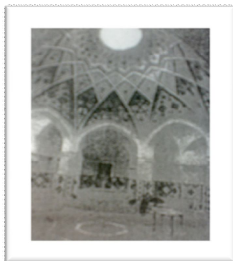
کاشان - حمام خان - شکل هورنو در بالای گنبد بصورت دایره نورگیر نمایان است
