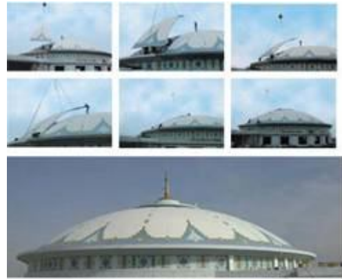
وزارت دفاع ترکمنستان، ساخت شرکت DK Composites، قطر گنبد ۲۸ متر.
