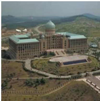
محل اقامت نخست وزیر مالزی، ساخت شرکت DK Composites، قطر گنبد ۲۶ متر.
