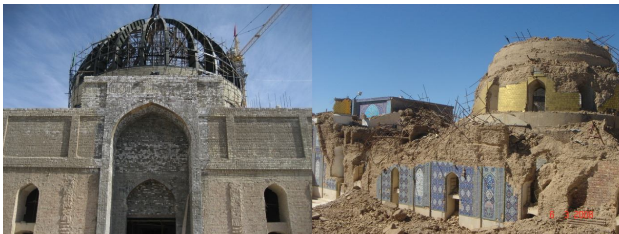
شکل ۶: سازه جدید گنبد ساختمان که از تیر ورق های فولادی تشکیل شده است.
